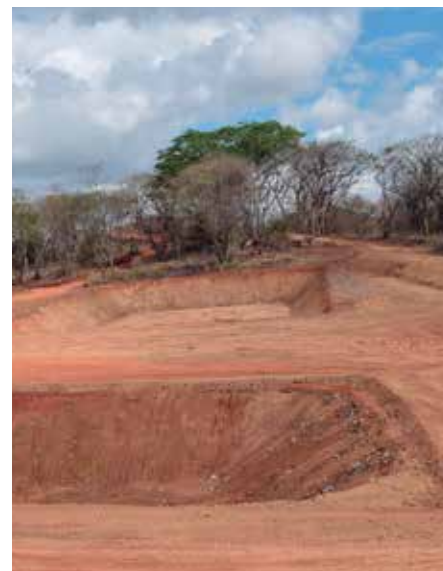
Trabajos en el Vertedero de Pedasí (2021)
